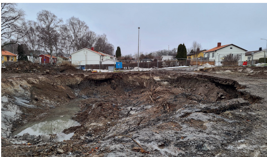
Obefintliga arbetsplattformar. En alltför vanlig syn på svenska byggarbetsplatser.
