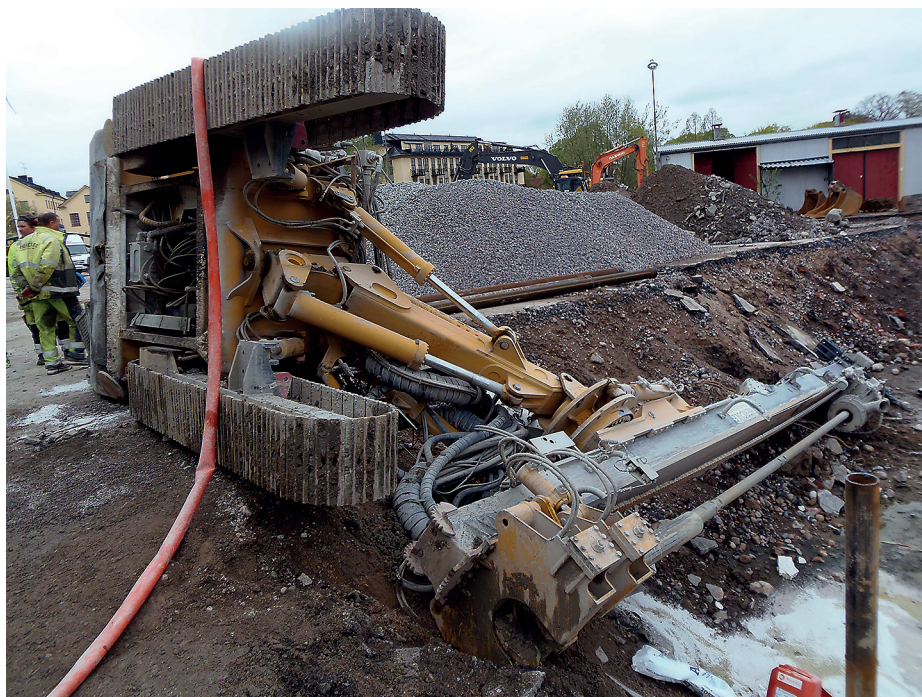
Pålmaskiner välter fortfarande.
