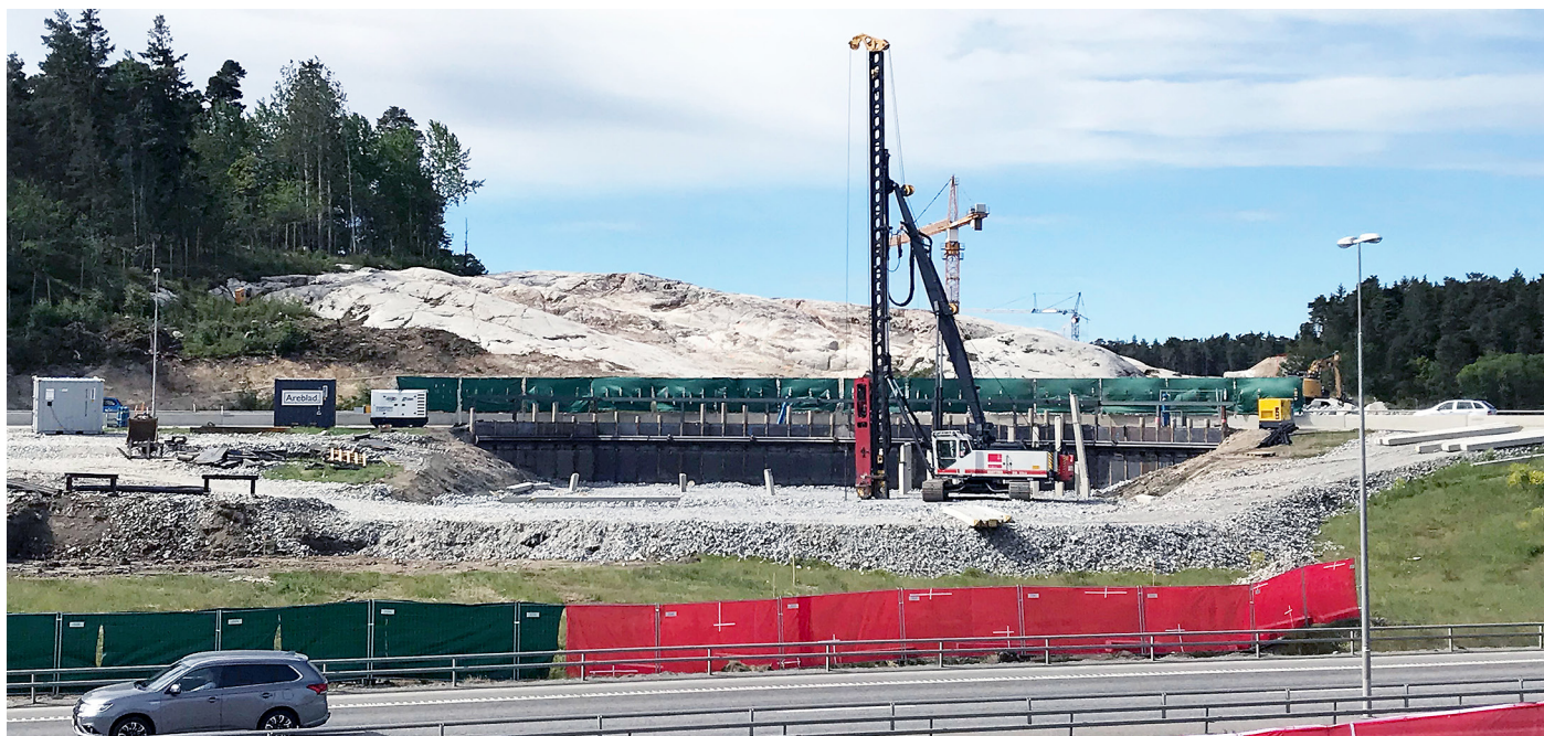
Med en trafikerad väg inom riskområdet måste maskinens stabilitet vara helt säkrad med en genomtänkt arbetsplattform.
