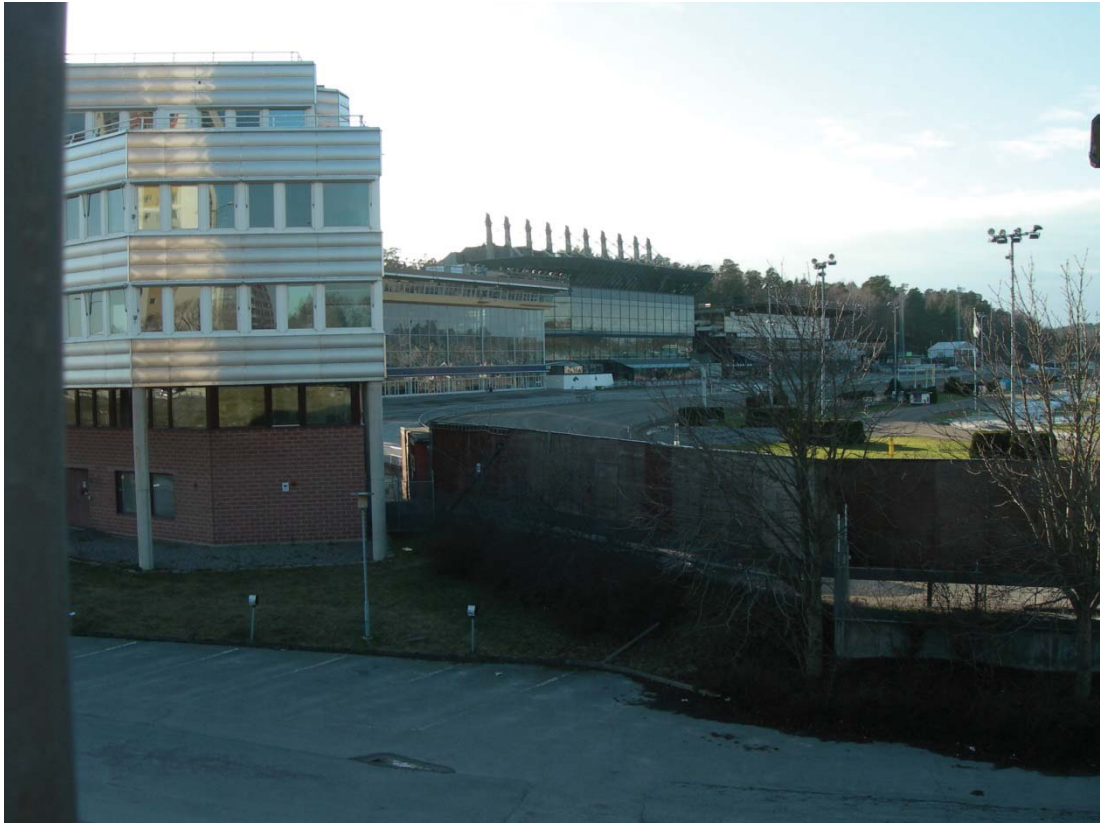
Figur 3 Arbetet med schaktning och spontning för utbyggnaden (t.v.) utfördes bara några meter från travbanan. Foto: Johan Spross.
